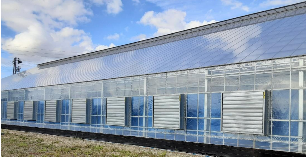
ファン側からの外観
